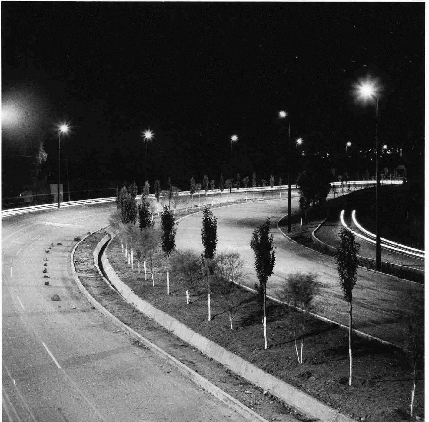
Vista nocturna del boulevard Guadalupe-Zacatecas, de 4.7 km de longitud y dos cuerpos centrales de 11 m, con tres carriles cada uno.
