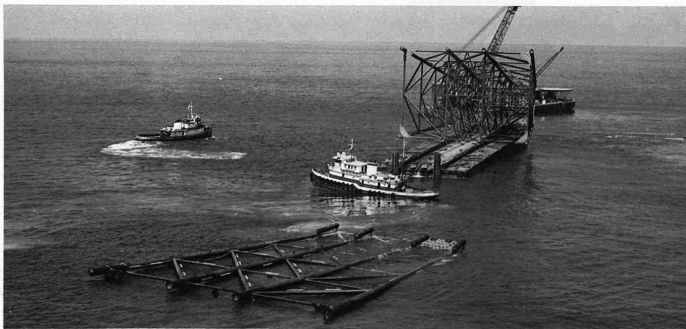
Maniobra de lanzamiento al mar de subestructura de dos plataformas de perforación, para su instalación definitiva.
