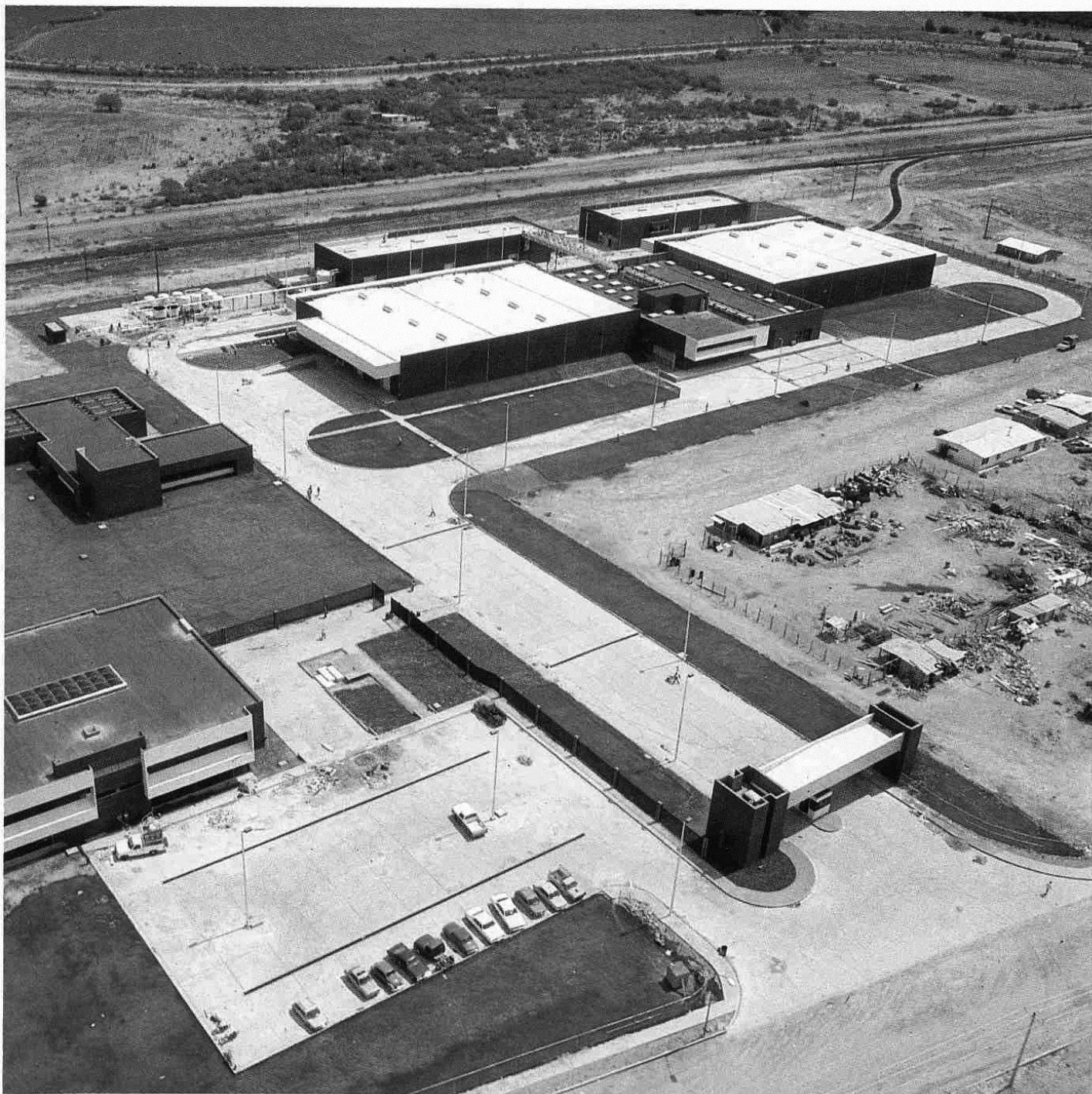
Toma aérea de las diversas instalaciones de la planta de LICONSA, que tendrá una producción de 8 mil litros de leche por hora; a la izquierda, interior de la sala UHT de proceso.
